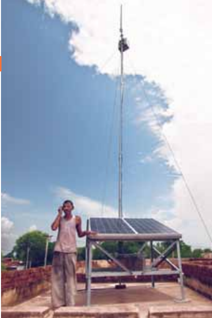
Mobilfunk Komplexe Technik, einfacher Betrieb
